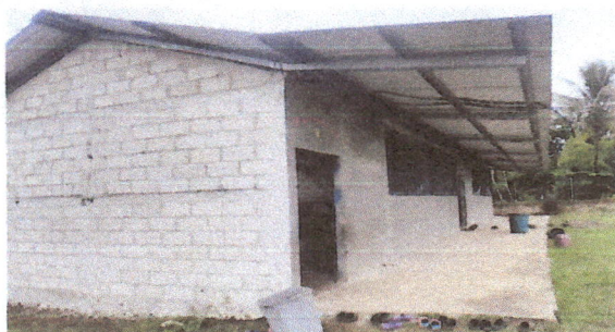
Aplicacion de pintura nueva.
