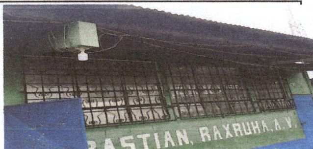
MODULO 3: SUSTITUCION DE CABLES ELECTRICOS: Cambio total del cableado electrico en todas las aulas.
