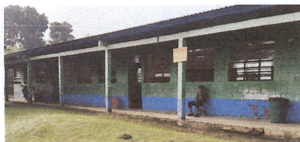
MODULO 4: PINTURA DE AULAS: Aplicación externa de pintura nueva en todas las aulas
